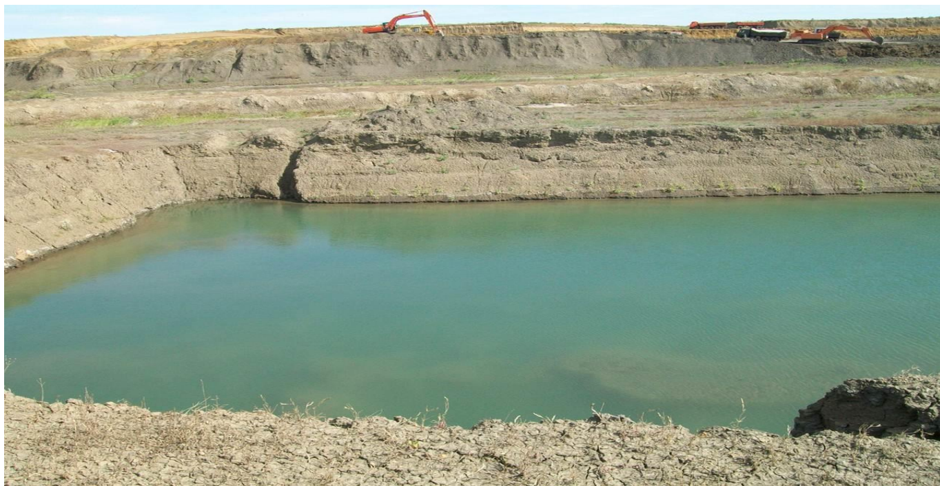
Рисунок 2.9 – Выход грунтовых вод, Южно-Оренбургское месторождение глины
